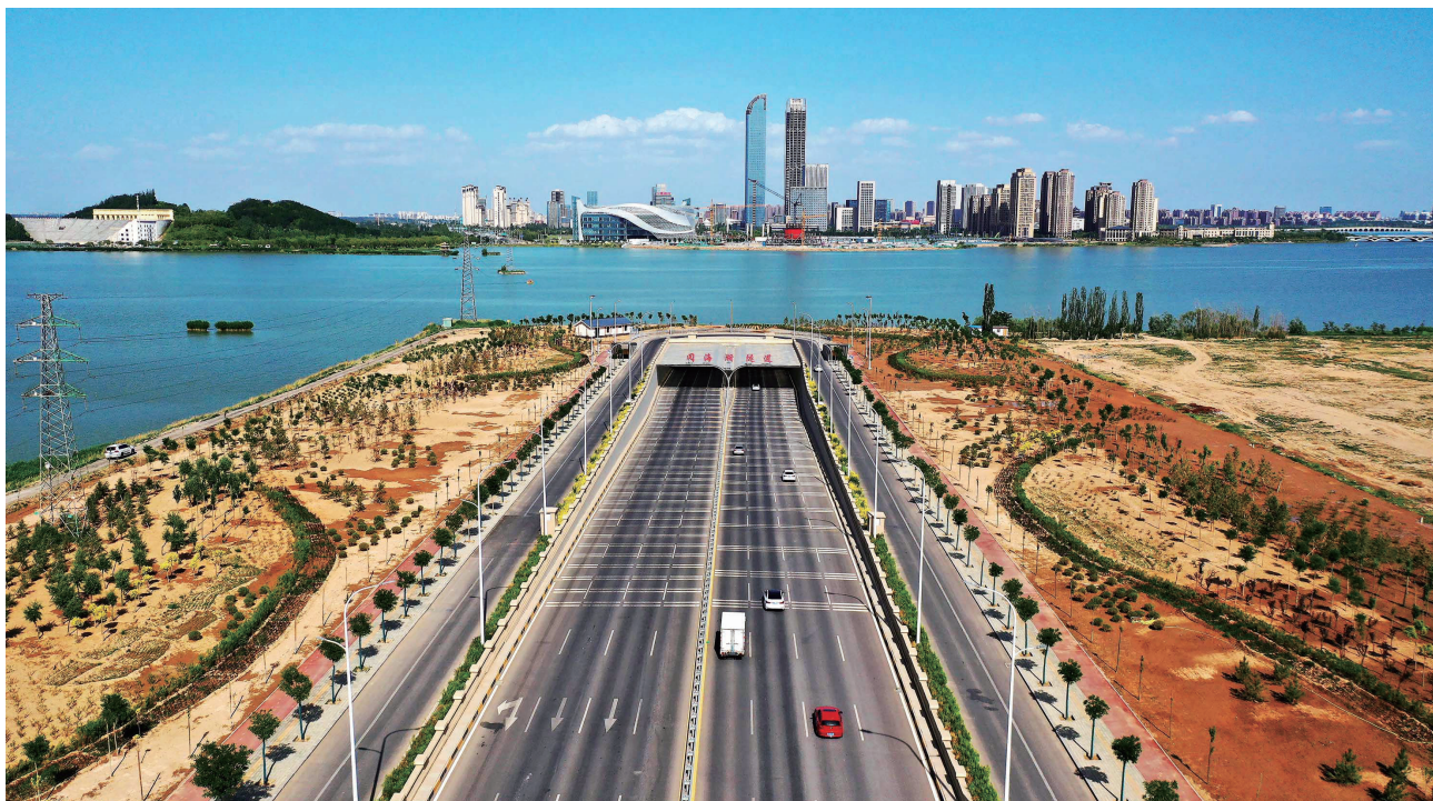
银川市加快城市建设进程，立体交通路网不断升级（图为2021年6月8日阅海湖隧道）（李靖 摄）
