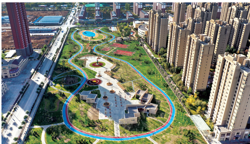
2019 年,银川市新建成的小微公园——福州南街游园
