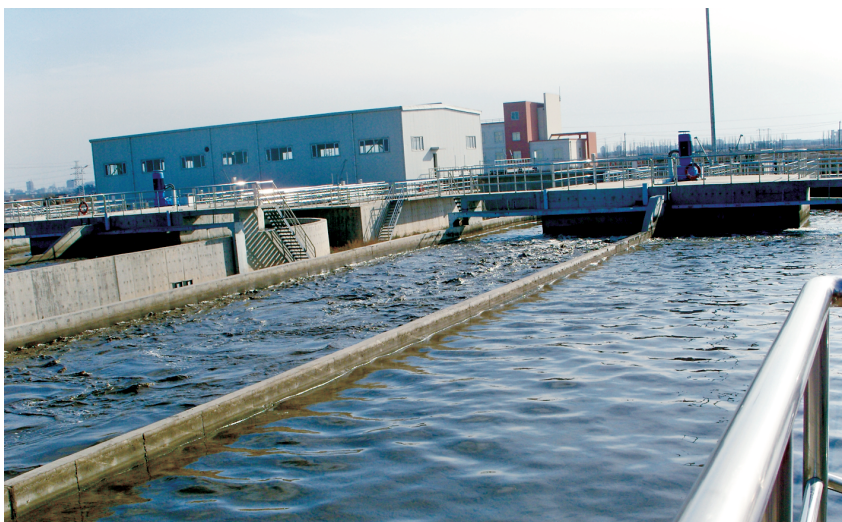
银川市第四污水处理厂主要污水处理设施——氧化沟
