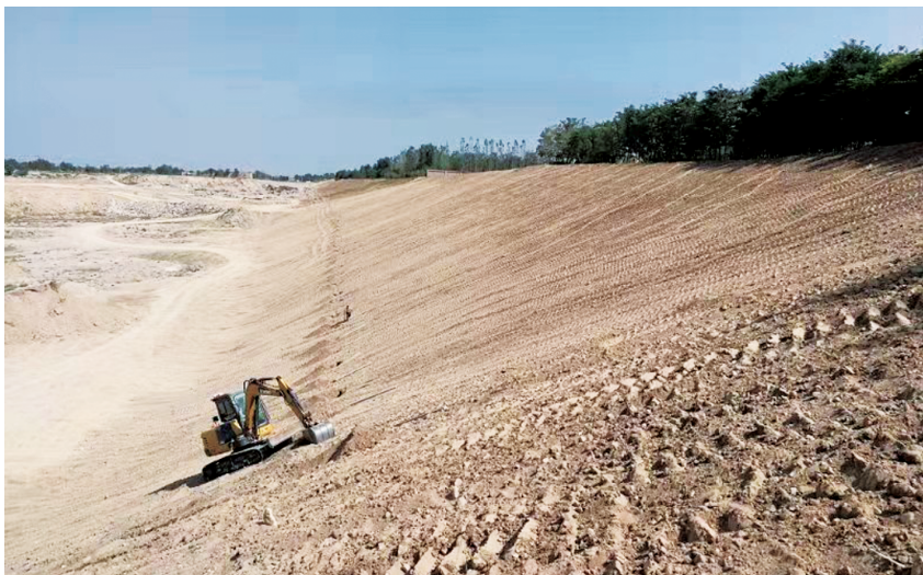
2019年,银川市自然资源局完成西夏区云山路南侧遗留矿坑陡坡除险整治工程 (市自然资源局 供图)
